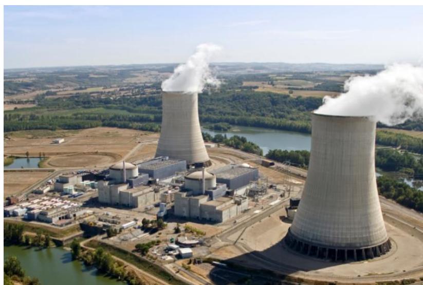
Vue de la centrale de Golfech (source : EDF Golfech)
